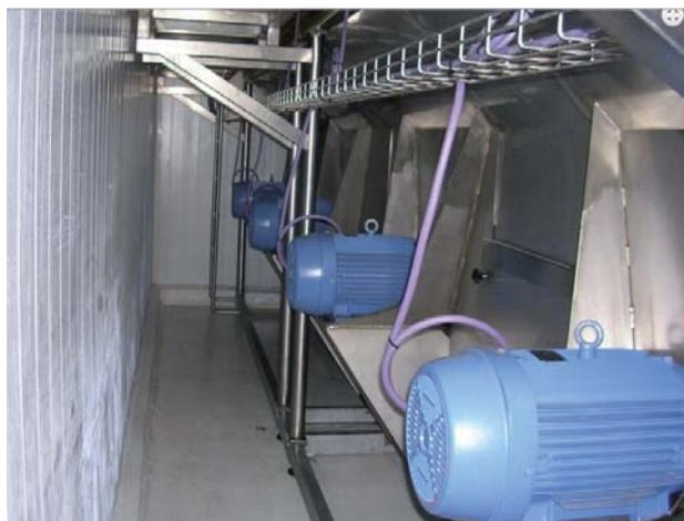
AISI 304. El accionamiento de las cintas es mediante moto-reductores comandados por variadores electrónicos de velocidad, lo que permite adaptar el tiempo de permanencia a las diferentes condiciones del producto a congelar.
